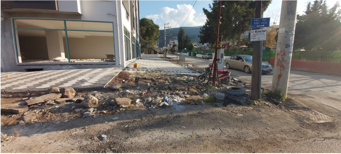
Görsel 8 – Moloz yığını ve kaldırım inşaatı
